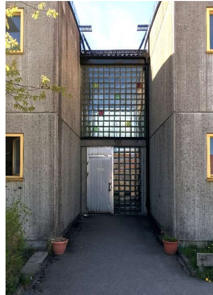
Nuvarande utseende, baksida. Detta är ett exempel, det varierar något mot baksidorna. Avsikten är att det ska som illustrationen till höger överallt. Vissa har ingen dörr mot baksida och idag vill man underlätta att ta sig direkt ut på gården, för slippa gå runt en hel länga.
