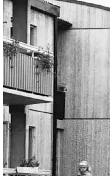
Inzoomning på trapphus som har balkongfront men ingen glasbetong.
